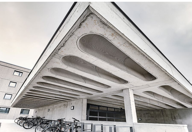
Tiefgaragendach mit 3D-gedruckten Betonschalen
