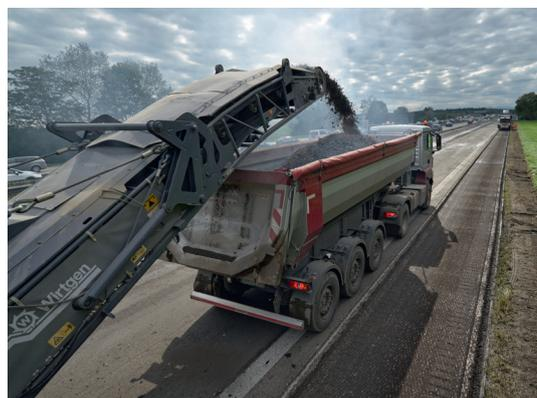
Gewinnung von Ausbausphalt, durch schichtenweises Fräsen, als Rohstoff für neuen Asphalt
